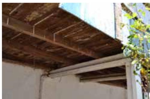
[69b]. Pormenor do encaixe da viga no muro.
