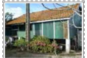
"Esta habitação mantém no geral a estrutura base destes edifícios, em madeira, revestido exteriormente por contraplacado com pintura, e cobertura em telha marselha. O espaço designado por "adega" foi construído posteriormente em alvenaria com pintura. A chaminé foi eliminada ou, eventualmente, nunca foi construída. Foi acrescentada uma garagem, construída em alvenaria, anexa ao edifício principal."
