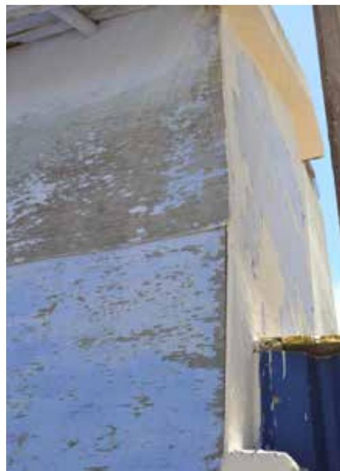
[45b]. Pormenor da espessura do reboco aplicado sobre o contraplacado; construção 2.
