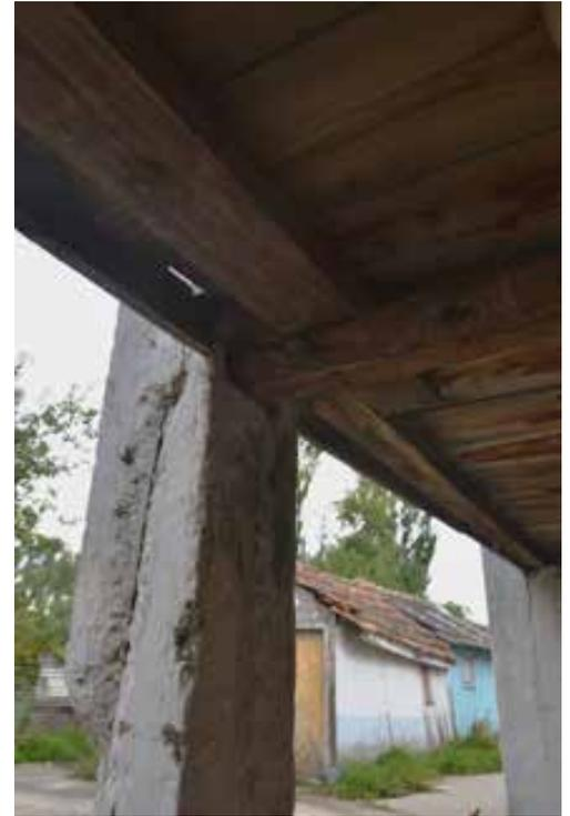
[70b]. Pormenor do encaixe da viga no pilar.
