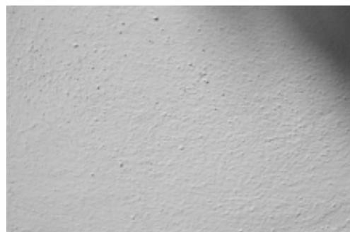
[46c]. Pormenor da textura da parede da construção 6; a superfície do revestimento é areada.
